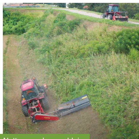
Nettoyage des remblais
