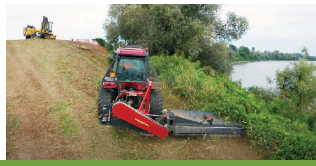
Czyszczenie nasypów wyłącznie przy użyciu Better
