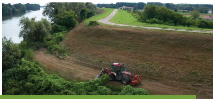
Czyszczenie nasypów wyłącznie przy użyciu Better
